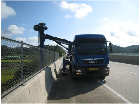
교량점검차를 이용한 근접조사
