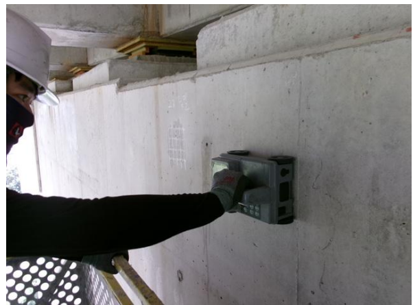
교량점검차를 이용한 근접조사
